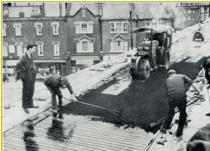
1969 Posa dell'asfalto sulla carreggiata superiore di un incrocio Hammerschmidt a Londra (Electric heating of the roadways, by Robert Félix, 1971, Ultimheat Museum*)
